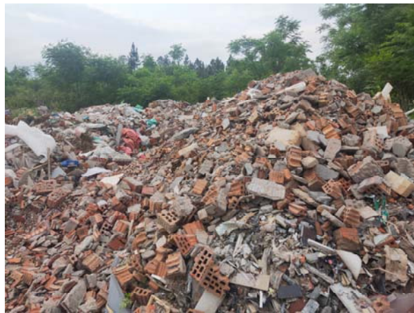
c) 工程垃圾/拆除垃圾
